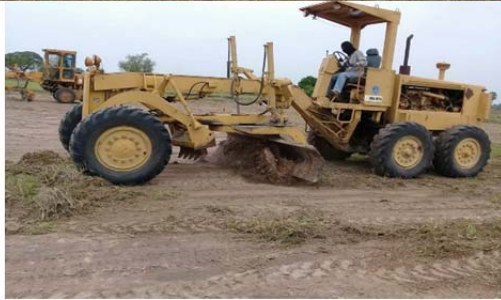
รูปที่ 4 แสดงเปิดแนวและหน้าดิน เพื่อขจัดวัชพืชหรือต้นไม้สิ่งกีดขวาง
